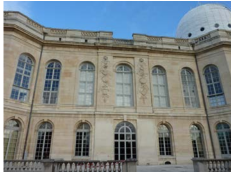
Figure 5 Façade sud du bât. Perrault ©Alexia Sagot
