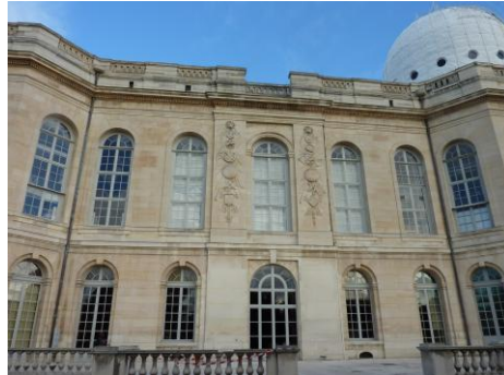
Figure 5 Façade sud du bât. Perrault ©Alexia Sagot
